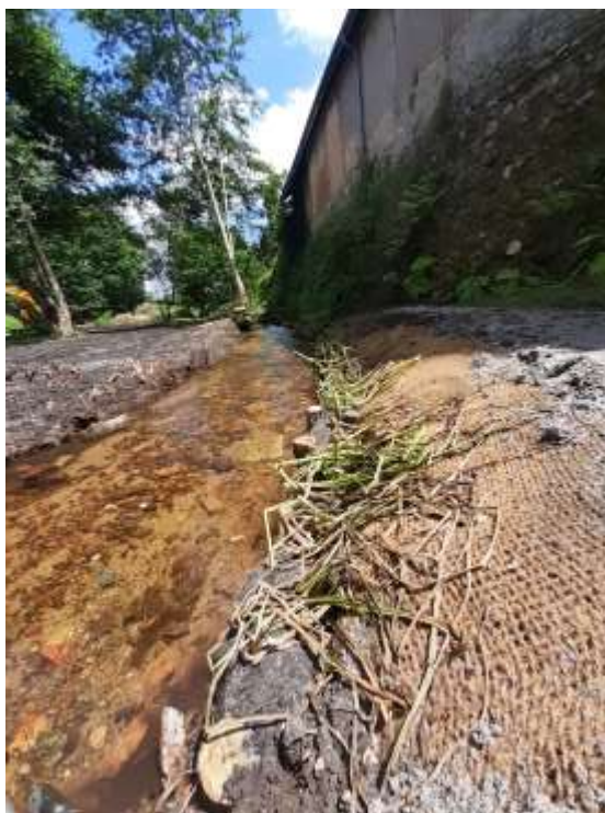
Terrassement de la berge opposée à la berge restaurée
