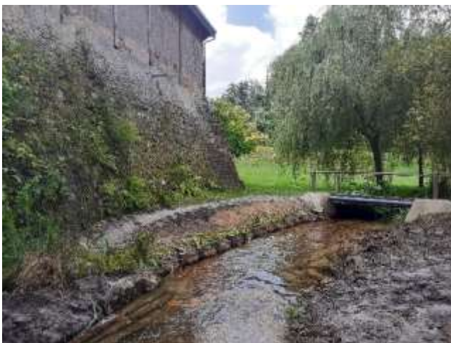
Restauration de berge
